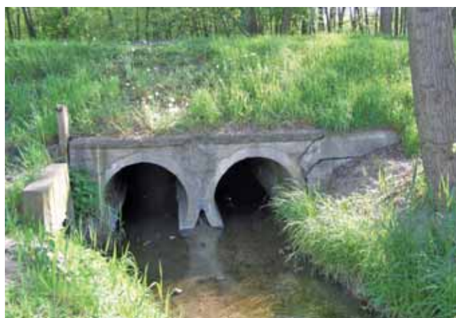
Ryc. 7. Dwukomorowy przepust drogowy bez możliwości migracji zwierząt [1]
