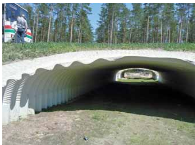
Ryc. 8. Widok przejścia dla zwierząt pod drogą krajową S3 wykonanego w technologii blach falistych SuperCor, fot. A. Wysokowski
