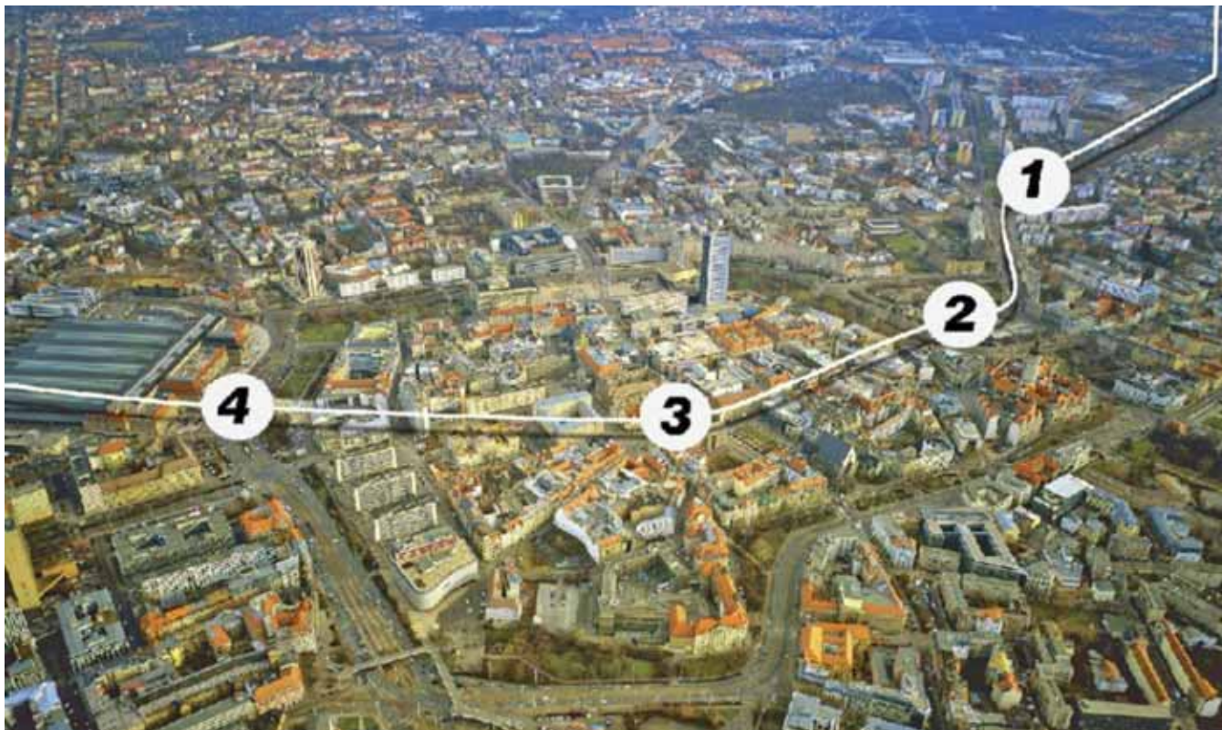
Trasa budowy metra: 1) Station Bayerischer Bahnhof (Dworzec Bawarski), 2) Station Wilhelm-Leuschner-Platz (Plac Wilhelma Leuschnera), 3) Station Markt (Rynek), 4) Station Hauptbahnhof (Dworzec Główny)
