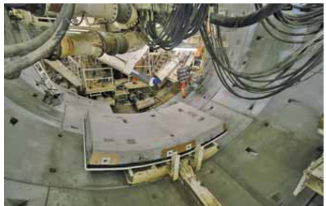
Budowa tunelu – obudowa tubingami
