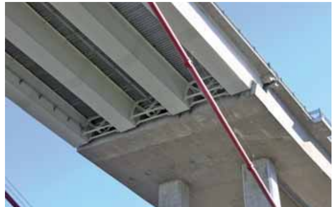
Połączenie mostu wiszącego z wiaduktem, fot. K. Dąbrowiecki
