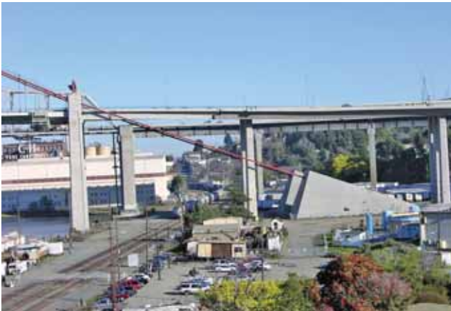
Zakotwienie po stronie południowej, fot. K. Dąbrowiecki
