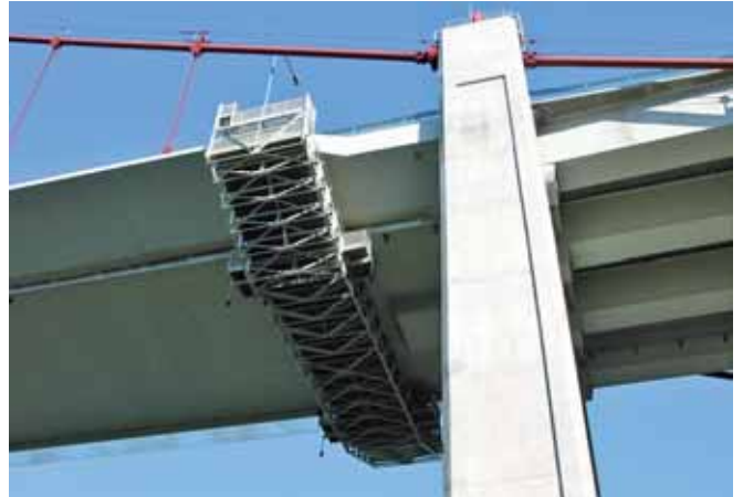
Ruchome rusztowanie do konserwacji pomostu, fot. K. Dąbrowiecki
