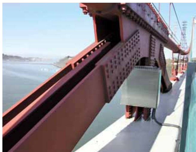
Zamocowanie kabla do pomostu w najniższym punkcie, fot. K. Dąbrowiecki
