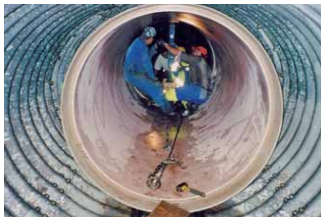
Ryc. 2. Wymiana wykładziny metalowego przepustu o znacznym odchyleniu
