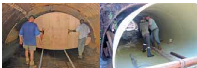
Ryc. 5. Sprawdzanie wewnętrznych wymiarów istniejącego przepustu oraz instalacja paneli
