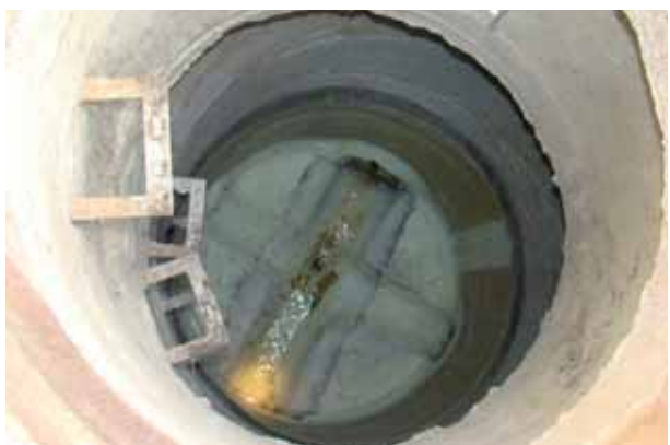
Studnia po renowacji
