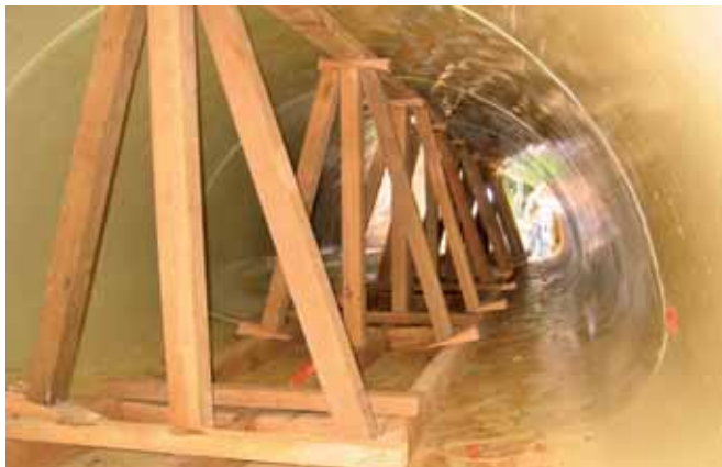
Ryc. 7. Widok drewnianej konstrukcji
