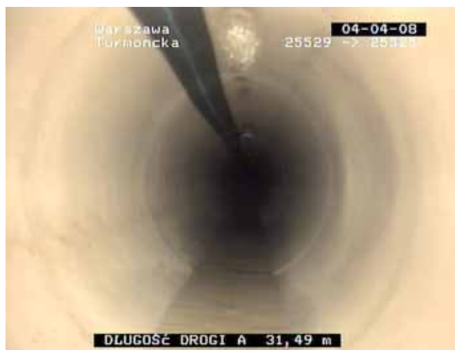
Zdjęcie kanału po zamontowaniu rękawa
