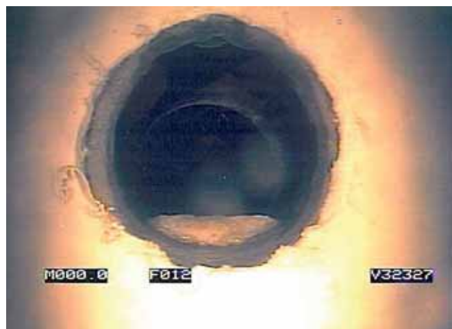
Zdjęcie kanału przed renowacją
