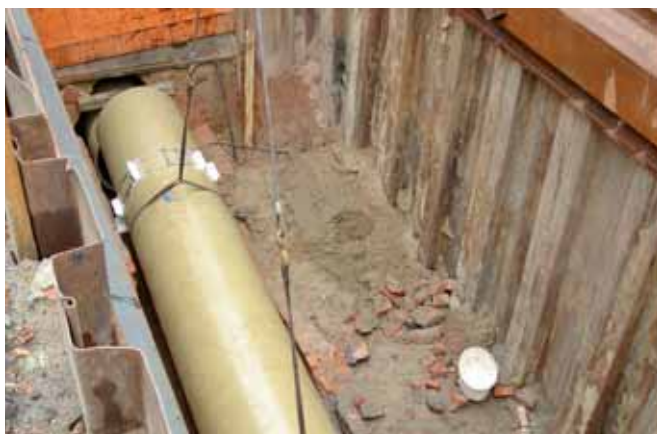
Rura GRP przygotowana do osadzenia w kanale
