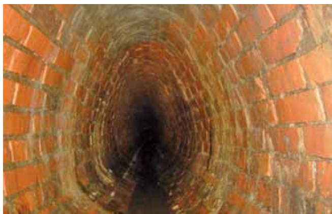
Kanał ceglany, jajowy 700/1050 w ul. Hallera w Gdańsku
