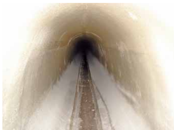
Widok wnętrza zainstalowanej wykładziny CIPP
