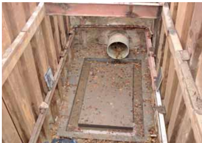
Zabudowa komór na nowym rurociągu
