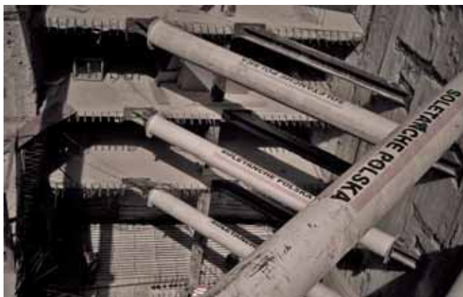
Rozparcie ściany szczelinowej w rejonie rampy
