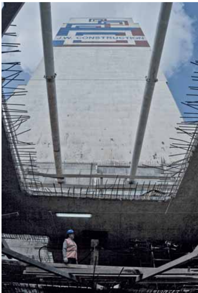
Otwór w stropie tymczasowym z widokiem rozparcia w poziomie górnym
