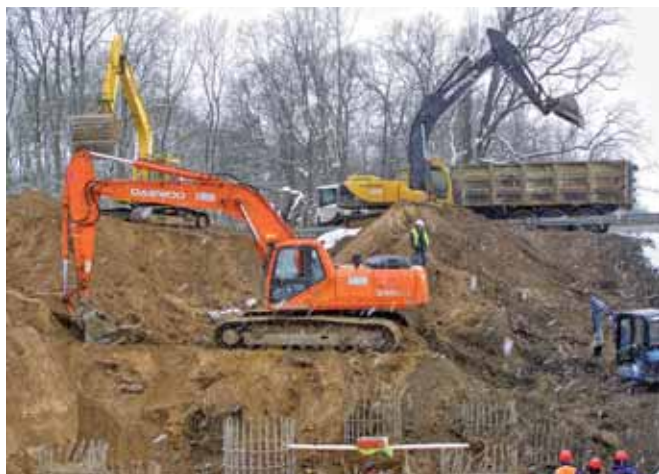
Wykop fundamentowy, podpora P-13
