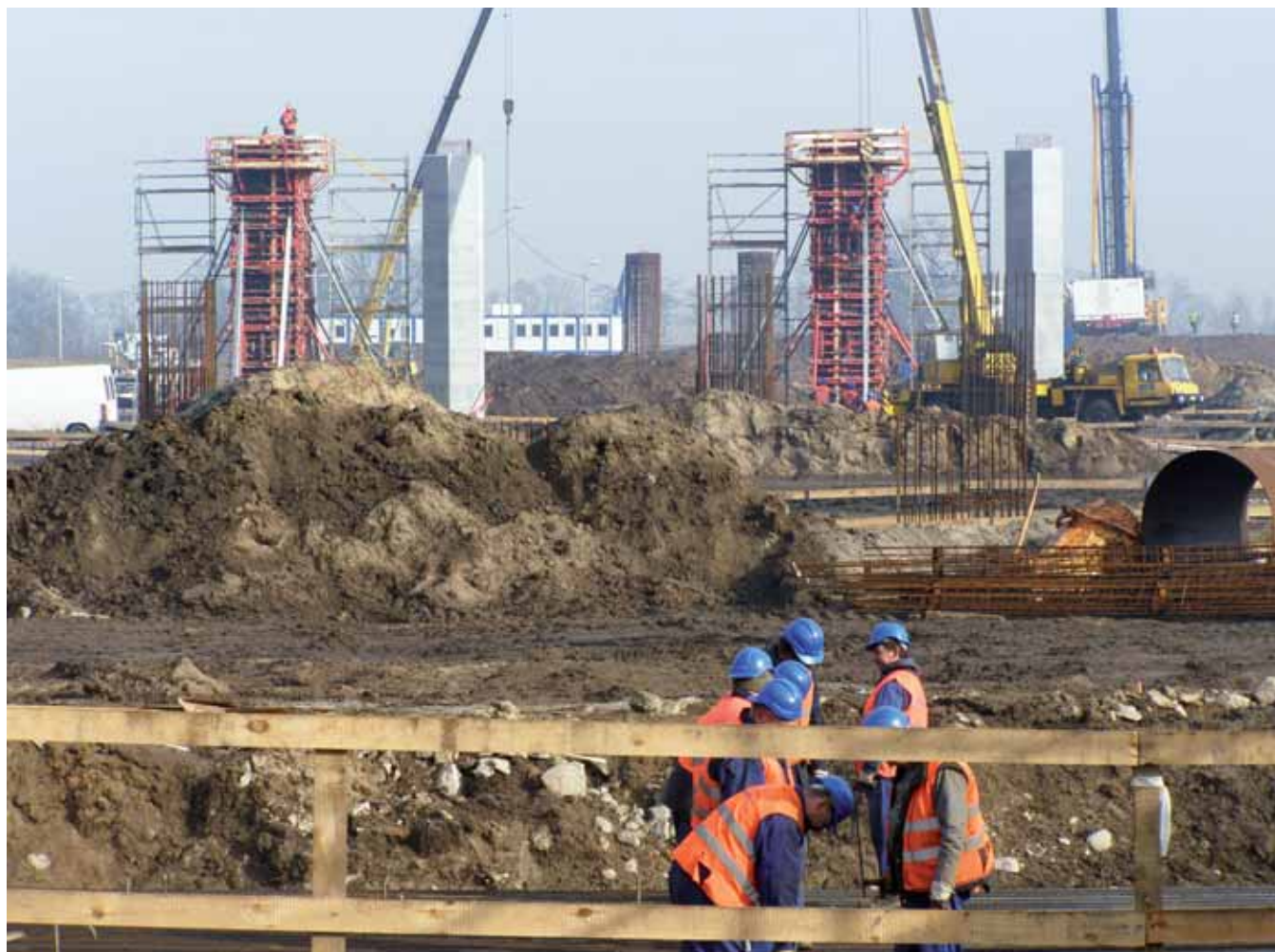
Widok na plac budowy estakady E3
