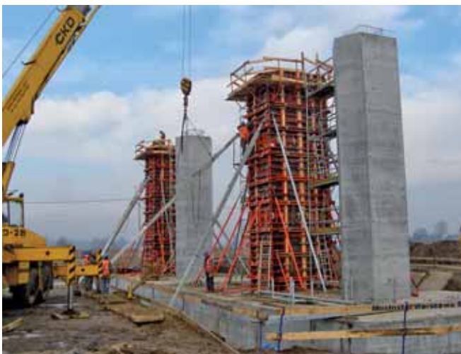
Zbrojenie i betonowanie filarów – podpora P19
