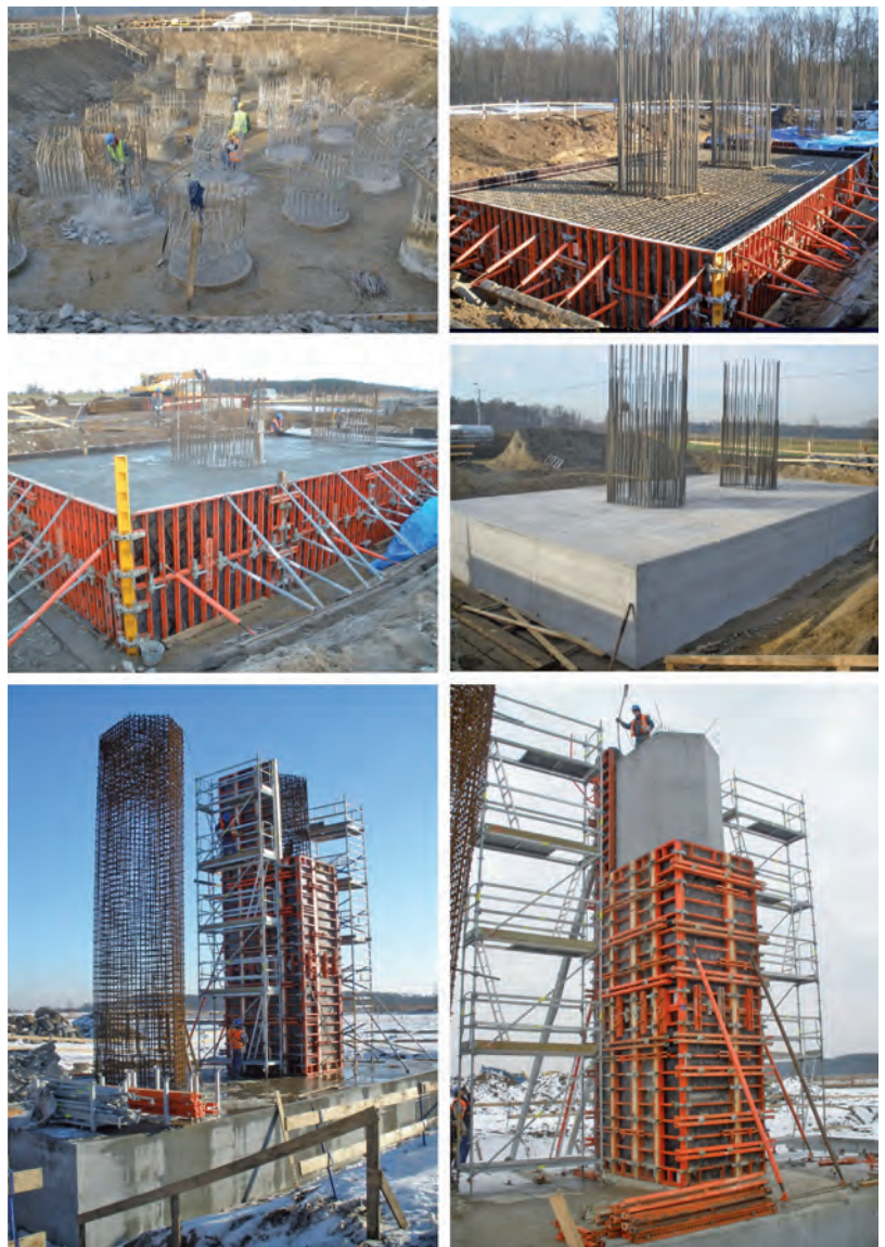
Ryc. 13. Budowa podpór posadowionych na palach wierconych
