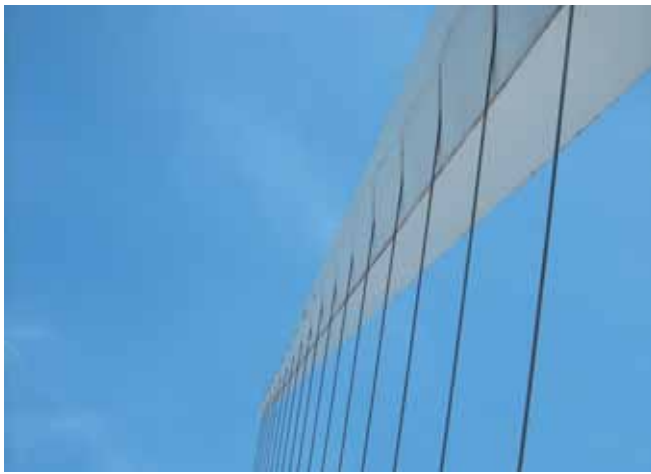
Most Puente de La Mujer – zamocowanie want do pylonu
