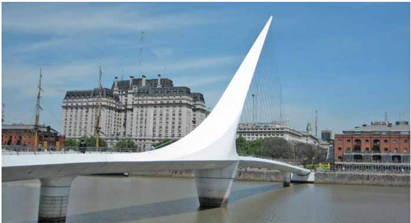
Most Puente de La Mujer – podpora obrotowa
