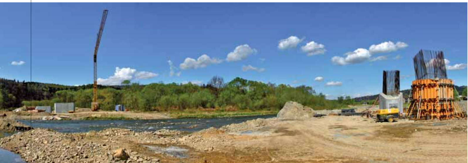
Panorama miejsca budowy obiektu w Zembrzycach
