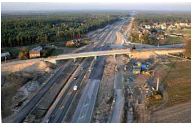
Budowa drogi ekspresowej S8, odcinek Radzymin – Wyszków
