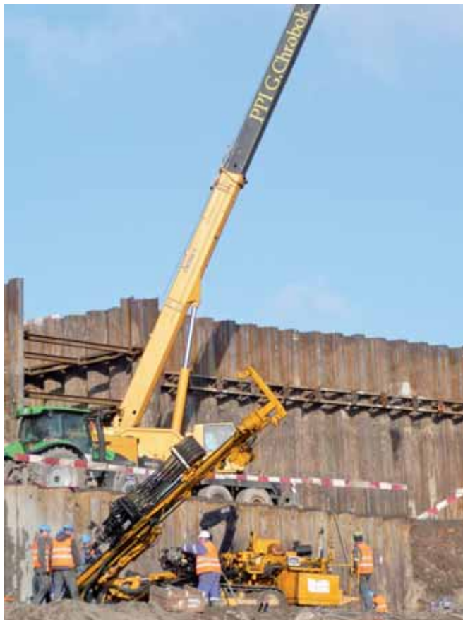
Proces wykonawczy kotew oraz oczepów i rozpór
