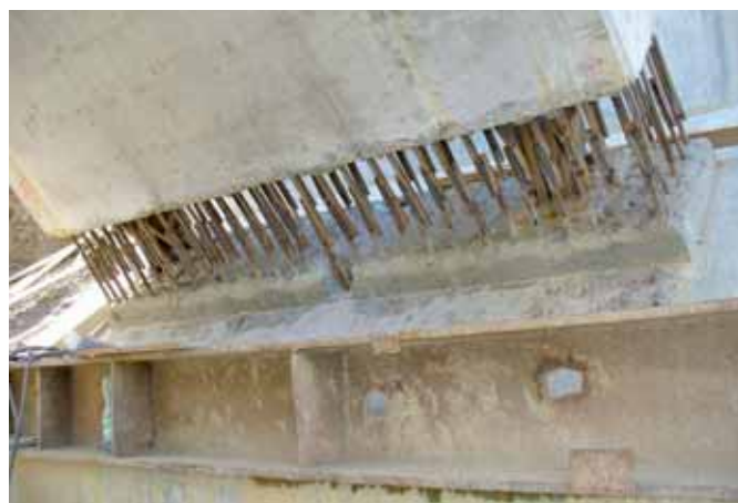
Przeguby do zabetonowania
