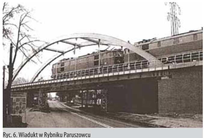
Ryc. 6. Wiadukt w Rybniku Paruszowcu
