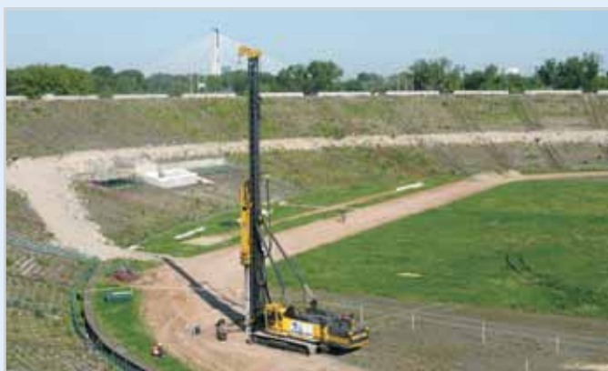
Stadion Narodowy w Warszawie - pale testowe, stanowisko testowe nr 13
