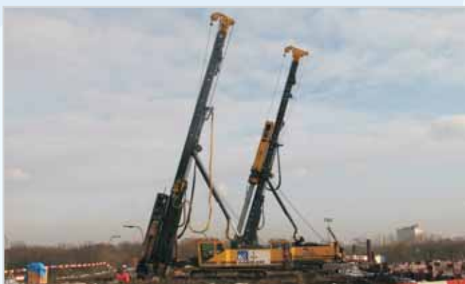
Pale prefabrykowane skośne 40 x 40 cm o długości do 27m na koronie stadionu
