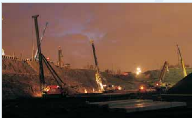
Palowanie zasadnicze pod trybuny stadionu przy mobilizacji dziesięciu zespołów roboczych - pale prefabrykowane wbijane 40 x 40 cm
