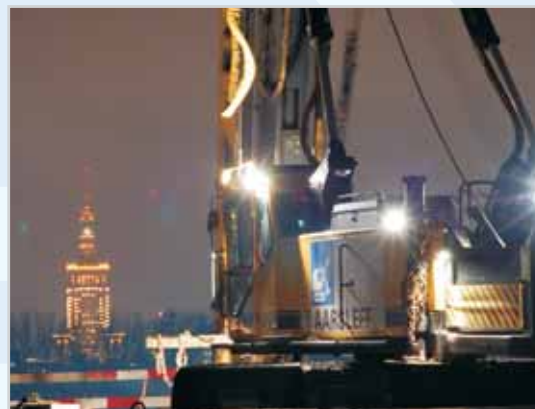
Palowanie zasadnicze pod trybuny stadionu przy mobilizacji dziesięciu zespołów roboczych - pale prefabrykowane wbijane 40 x 40 cm
