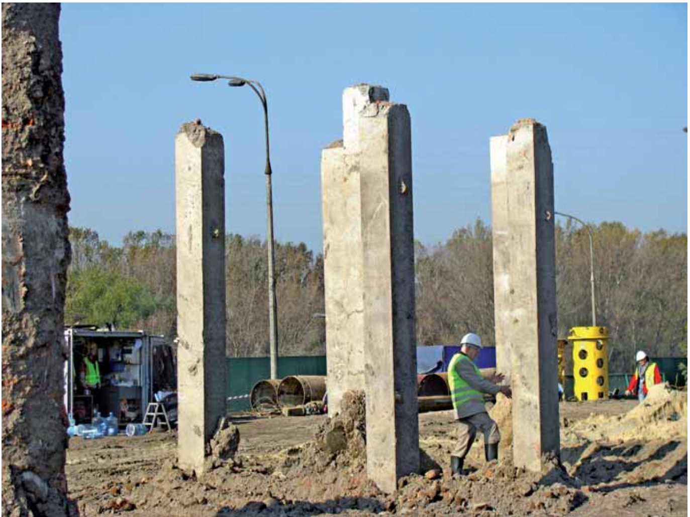
Ryc. 8. Odkryte pale prefabrykowane
