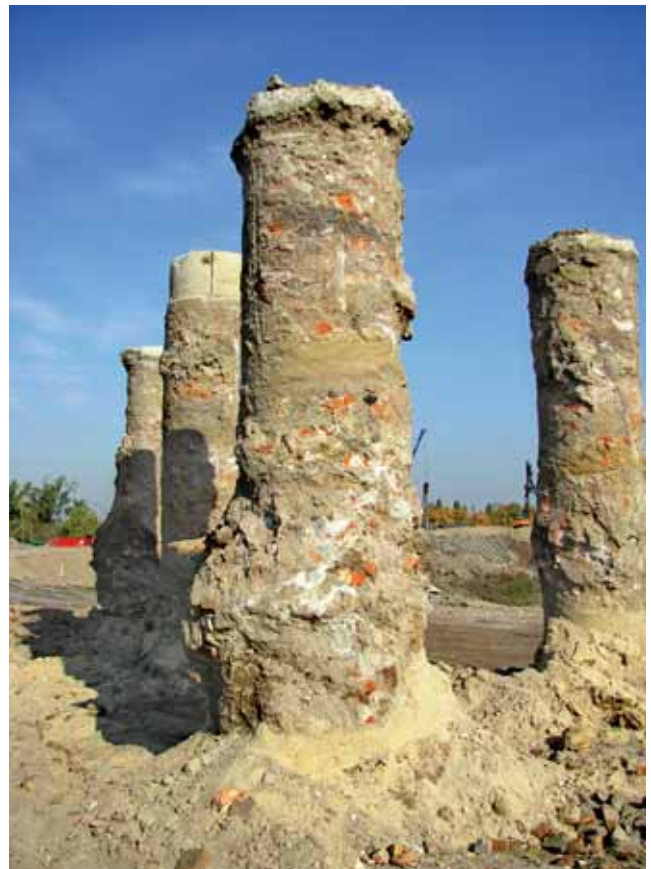
Ryc. 9. Odkryte pale wielkośrednicowe
