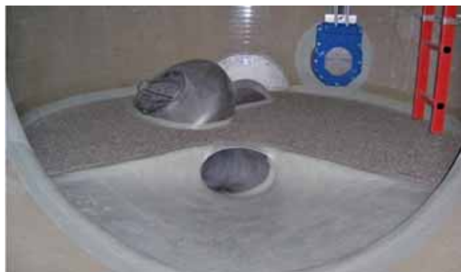
Ryc. 8. Widok ogólny i wewnątrz studni regulacyjnej Flowtite jako budowli odciążającej wraz z wirowym regulatorem przepływu
