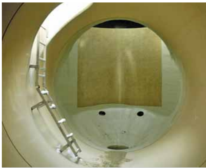
Ryc. 6. Wnętrze studni kaskadowej
