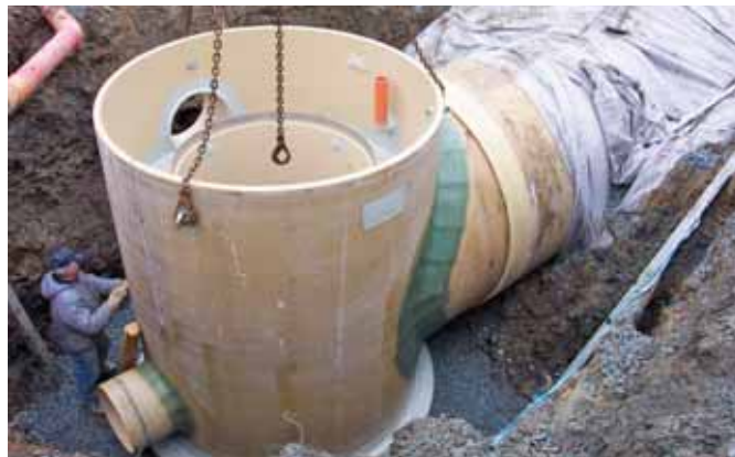
Ryc. 7. Posadowienie komory odciążającej i jej montaż z kanałem retencyjnym
