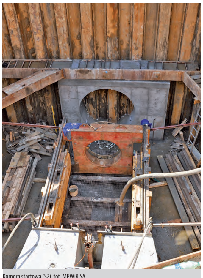
Komora startowa (S2), fot. MPWiK SA
