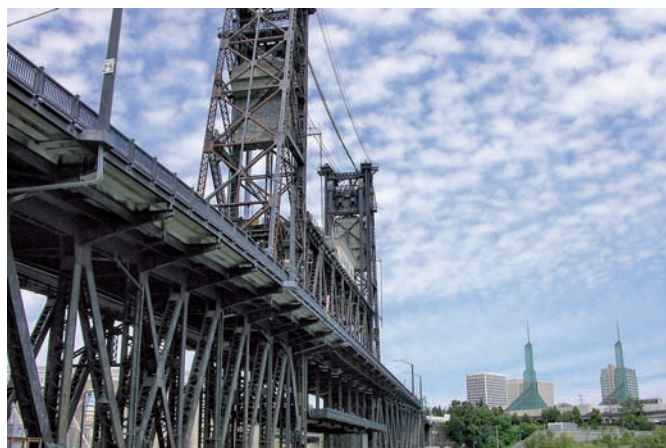
Most Steel z podniesionym pomostem kolejowym
