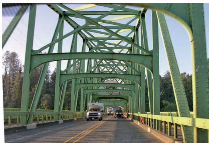
Most Umpqua River w Reedsport – przejazd przez przęsło obrotowe
