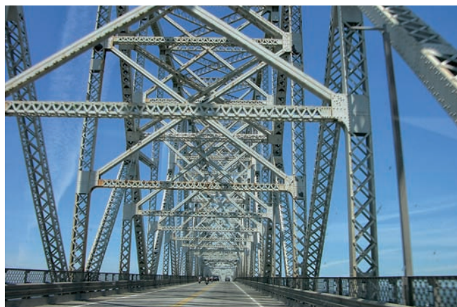
Most Lewisa i Clarka – kratownica części wspornikowej
