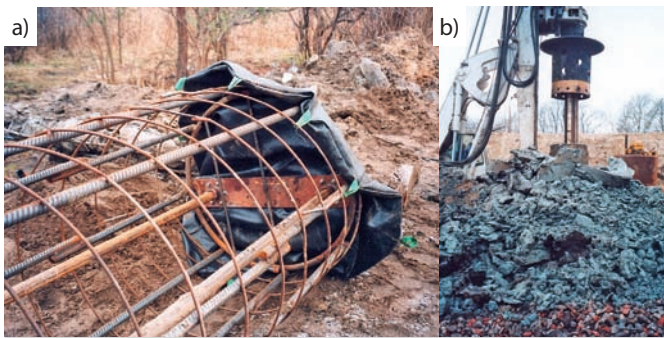
Ryc. 2. Most przez rzekę Brdę w Bydgoszczy: a) zbrojenie pala \varnothing 1200 mm z komorą iniekcyjną, b) wiercenie pala w ilach pęczniących
