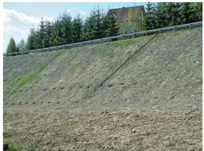
DK 69 – Zabezpieczony osuwiskowy korpus drogowy w miejscowości Węgierska Górka
