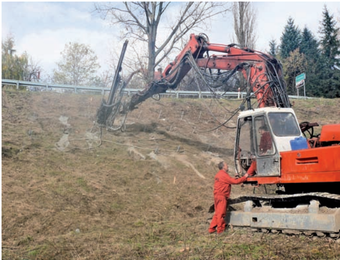
DK 69 – Wykonywanie gwoździ gruntowych systemu TITAN
