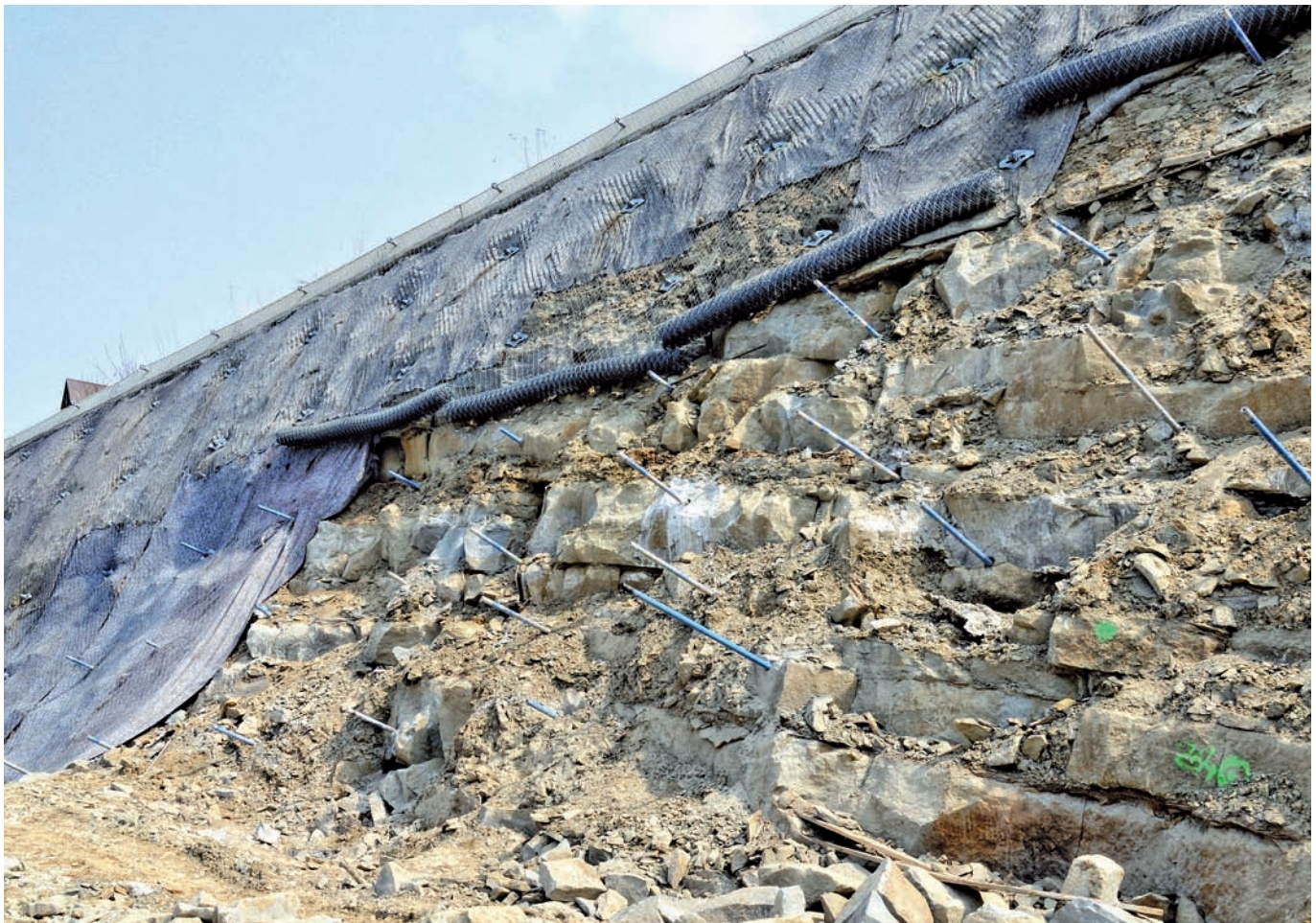
DE S7 – Lubień, zagwoździwana skarpa w trakcie mocowania systemu TECCO
