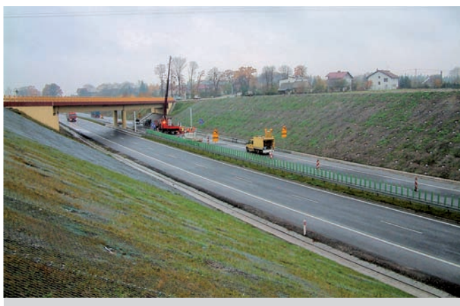
DE S1 – Widok skarp osuwiskowych po zabezpieczeniu
