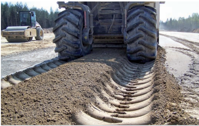
Mieszanie spoiwa z użyciem stabilizatora gruntu i grunt po przemieszaniu
