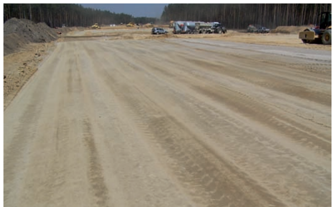
Grunt po stabilizacji spoiwem Terramix F
