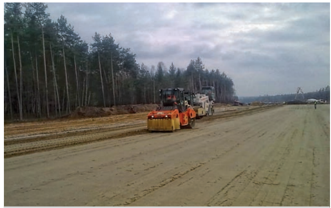
Równanie i wałowanie gruntu
