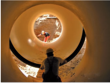
Ryc. 15. Przepust o dużej średnicy z rur kompozytowych CC-GRP w fazie realizacji, fot. Hobas
