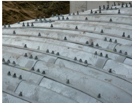
Ryc. 24. Przepust drogowy z blach falistych Multiplate w fazie realizacji. Widoczne połączenia śrubowe poszczególnych segmentów konstrukcji, fot. A. Wysokowski
