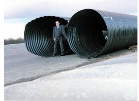
Ryc. 19. Stalowe karbowane spiralne rury przepustowe gotowe do wbudowania w nasyp drogowy, fot. A. Wysokowski
