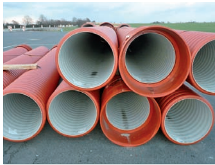
Ryc. 8. Rury z PP firmy Wavin składowane przed wykorzystaniem przy przebudowie drogi nr 94 na Dolnym Śląsku, fot. A. Wysokowski
