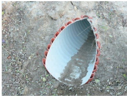
Ryc. 11. Przykład realizacji przepustu tymczasowego z rur PP. Widoczna możliwość dowolnego formowania wlotu i wylotu przepustu, fot. A. Wysokowski
