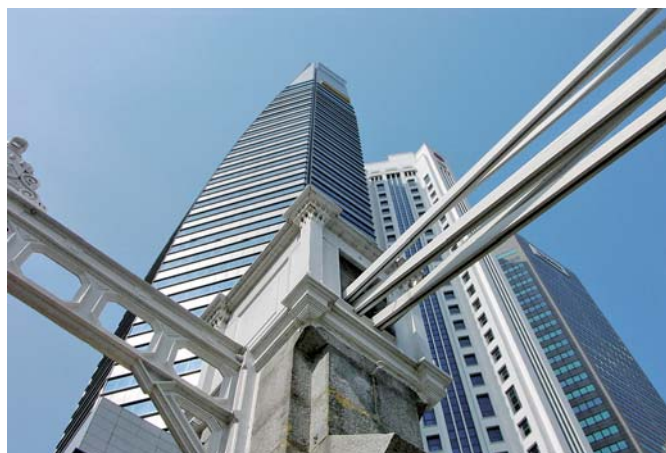
Pylon mostu Cavenagha na tle okolicznych wieżowców
