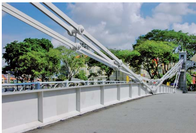
Element nośny mostu Cavenagha
