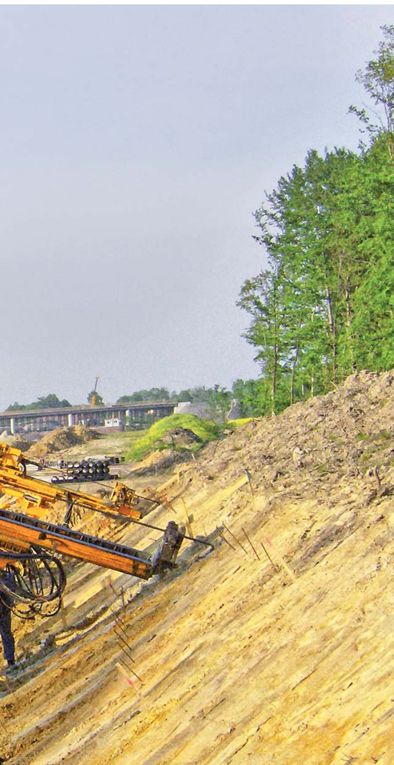
Skarpa z wykonanymi gwoździami gruntowymi oraz zamocowaną siatką
