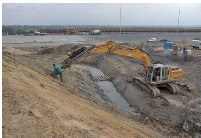
Wykonywanie gwoździ na wysokiej skarpie
