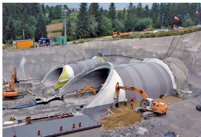
Budowa tuneli Emilia w Lalikach
