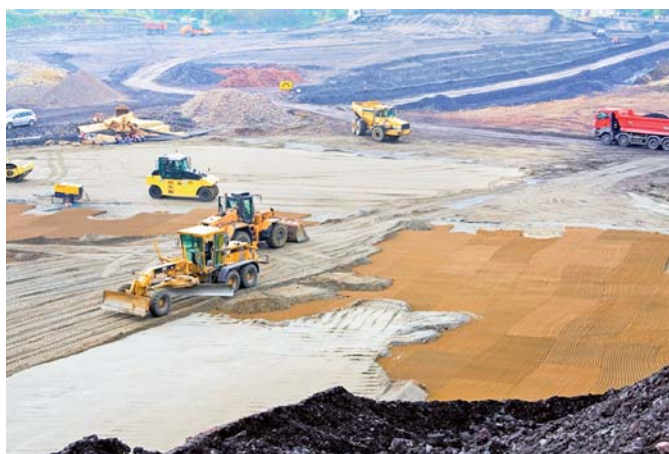
Budowa autostrady A1 Świerklany – Gorzyczki
