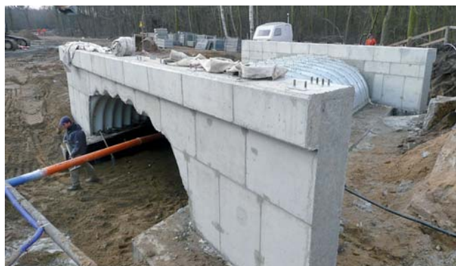
Przepust drogowy w trakcie budowy
