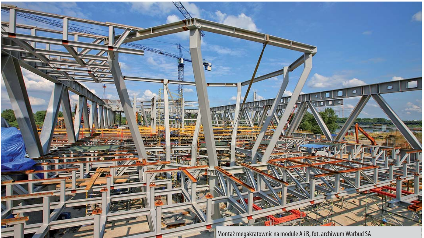
Montaż megakratownicy na module A i B, fot. archiwum Warbud SA
