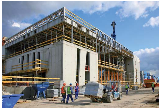
Plac budowy CNK, fot. archiwum Warbud SA
