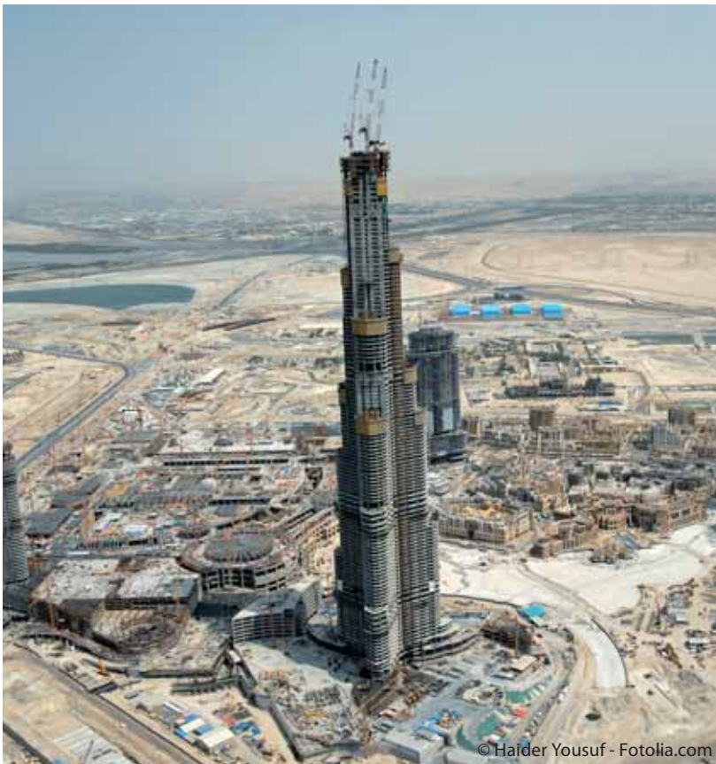
Wieża Dubaju w trakcie budowy
