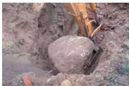
Ryc. 8. i 9. Głazy w miejscu posadowienia XIX w. kamienicy w rejonie szybu startowego K 36 przy ul. Zakroczymskiej, fot. Z. Rekuć
