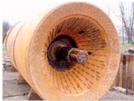
Ryc. 2. Głowica mikrotunelowa ze zdemontowaną tarczą, fot. Z. Rekuć
