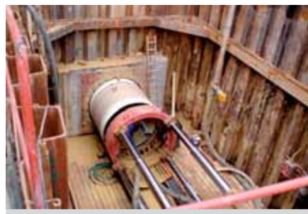
Ryc. 4. Maszyna AVN 1600 w komorze K 36 (ul. Zakroczymska), fot. Z. Rekuć
