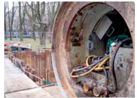
Ryc. 3. Wnętrze głowicy mikrotunelowej przy komorze K 20 (pl. Inwalidów), fot. Z. Rekuć
