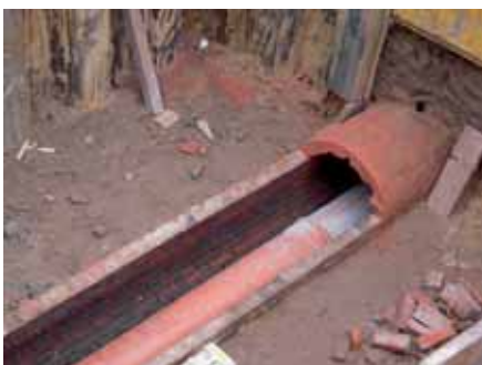
Ryc. 14 i 15. Budowa komory przelewowej na ul. Zakroczymskiej, nad czynnym kanałem Lindleya z 1896 r., fot. Z. Rekuć
