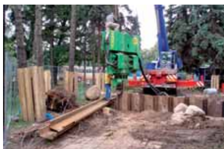
Ryc. 8. i 9. Głazy w miejscu posadowienia XIX w. kamienicy w rejonie szybu startowego K 36 przy ul. Zakroczymskiej, fot. Z. Rekuć
