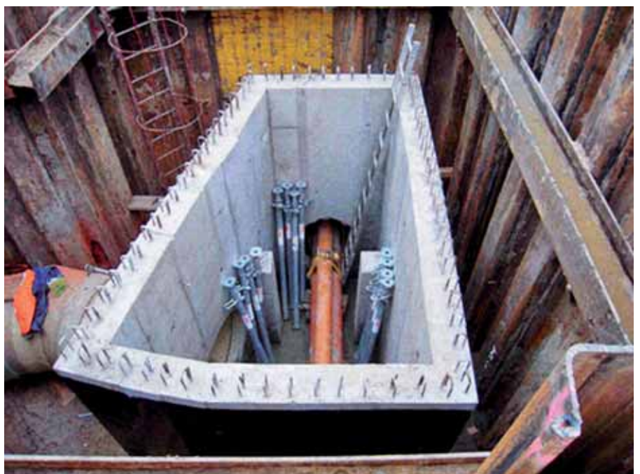
Ryc. 14 i 15. Budowa komory przelewowej na ul. Zakroczymskiej, nad czynnym kanałem Lindleya z 1896 r., fot. Z. Rekuć
