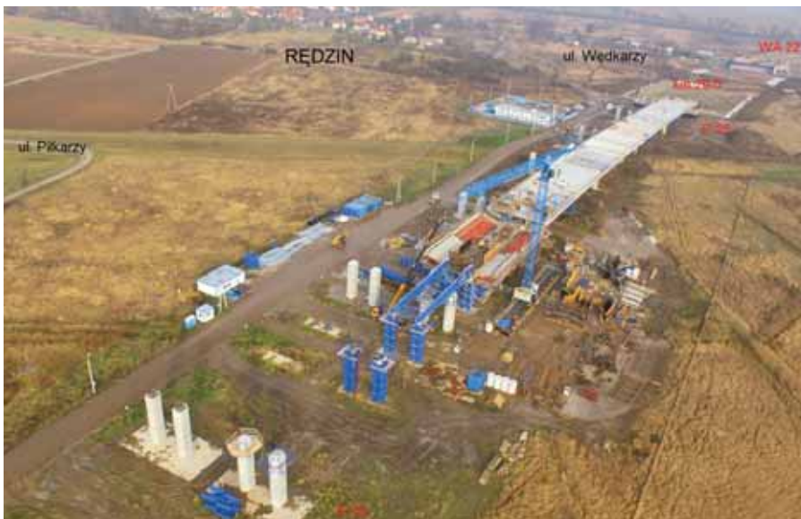
Most Rędziński jest częścią Autostradowej Obwodnicy Wrocławia
