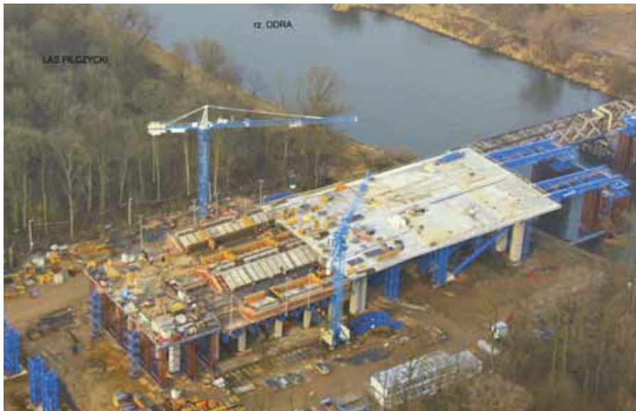
Budowa mostu Rędzińskiego - widok z lotu ptaka
