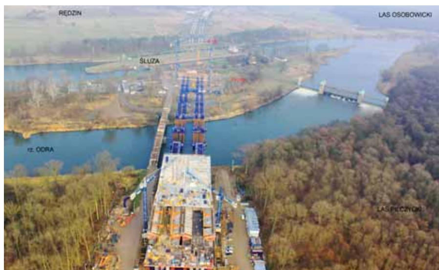
Budowa mostu Rędzińskiego przez Odrę we Wrocławiu
