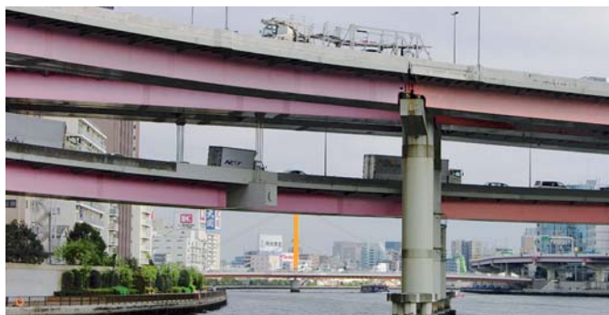
Estakady drogowe nad Sumidą
