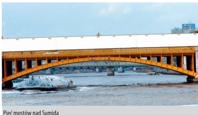
Pięć mostów nad Sumidą
