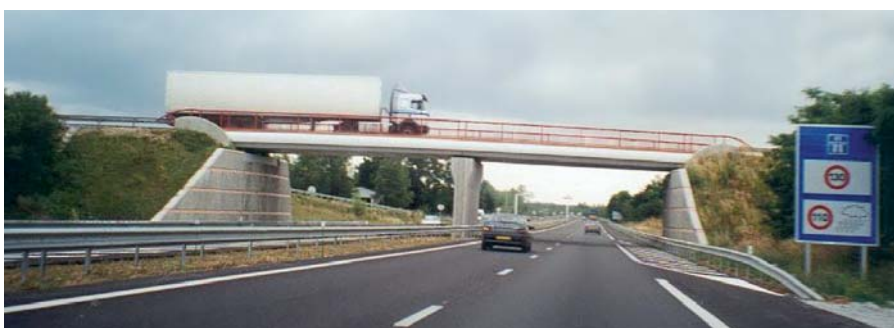
Ryc. 4. Wiadukt dwuprzęsłowy w ciągu drogi na nasypie
