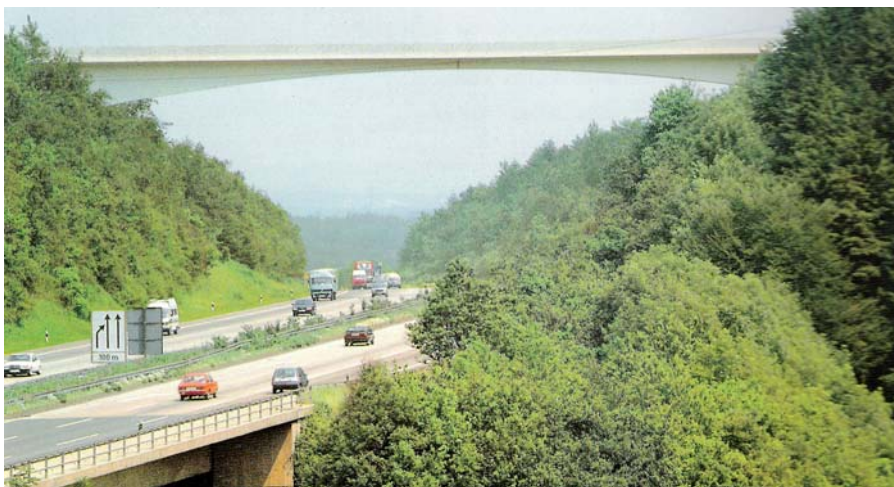
Ryc. 5. Jednoprzęsłowy wiadukt oparty na stromych, wysokich skarpach
