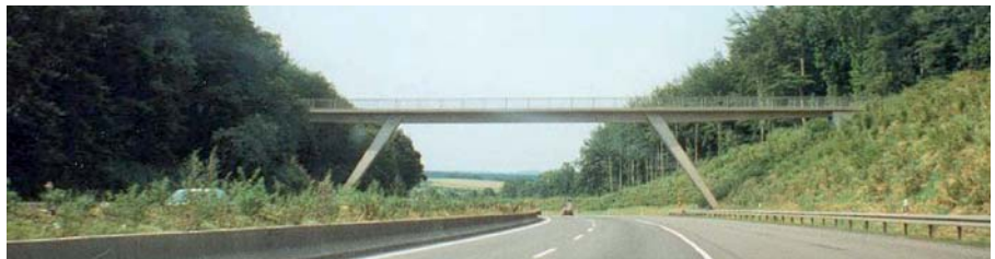
Ryc. 12. Trójprzęsłowy wiadukt ramowy
