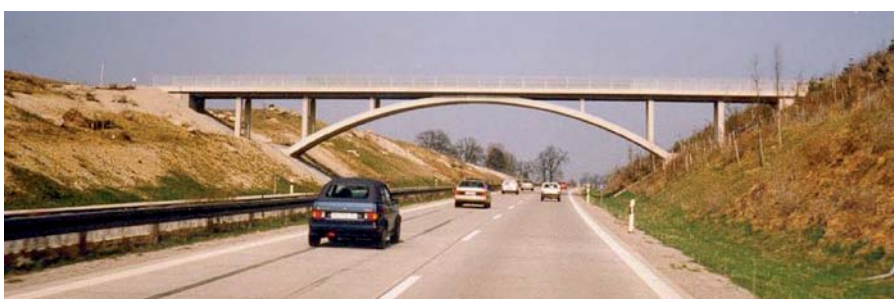
Ryc. 3. Jednoprzęsłowy wiadukt o konstrukcji łukowej (Niemcy)
