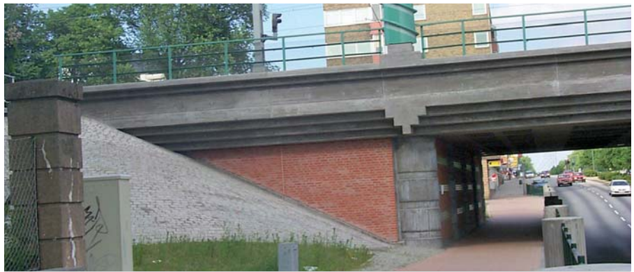
Ryc. 10. Redukcja wysokości konstrukcyjnej w masywnym wiadukcie
