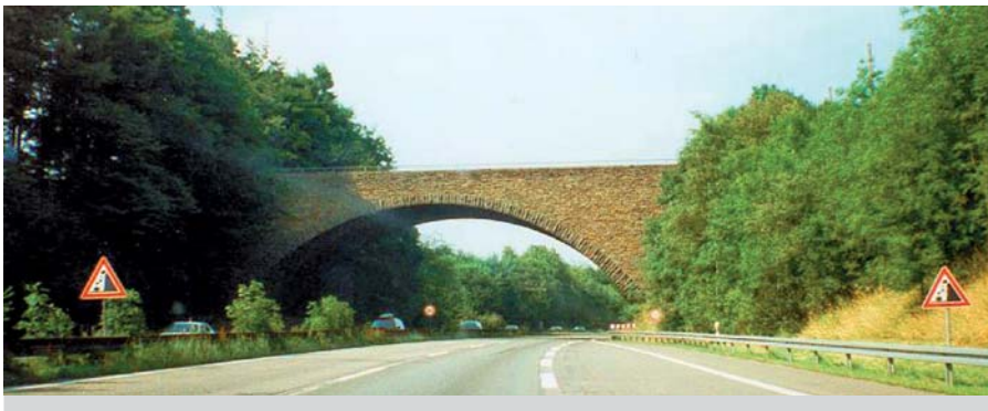
Ryc. 8. Wiadukt łukowy z murowanymi ścianami czołowymi
