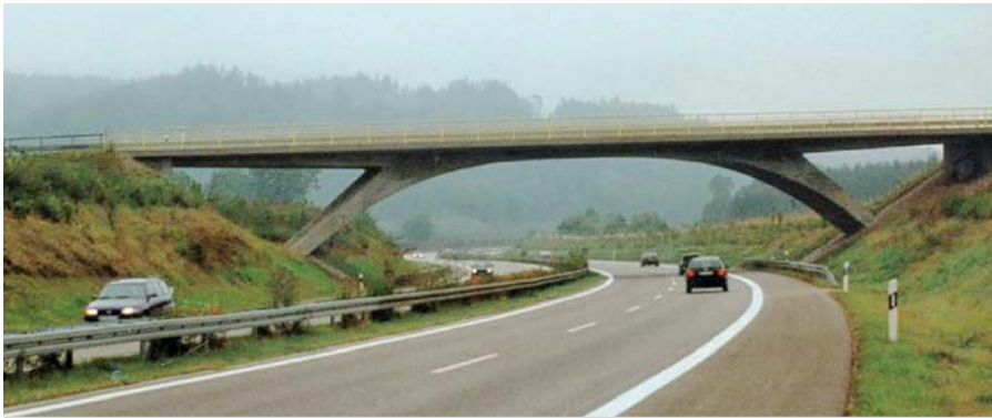
Ryc. 6. Konstrukcja ramowa pozwala uniknąć podpory między jezdniami. Na ostrym zakręcie, przy wąskim pasie rozdziatu, spełnienie tego postulatu bezpieczeństwa jest szczególnie ważne
