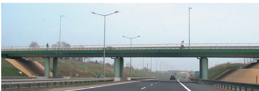
Ryc. 2. Czteroprzęsłowy wiadukt o lekkich podporach skrajnych (przyczółkach)
