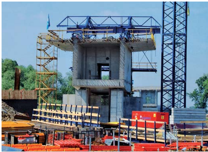
Ryc. 3. Widok na segment startowy nr 0 nad podporą D
