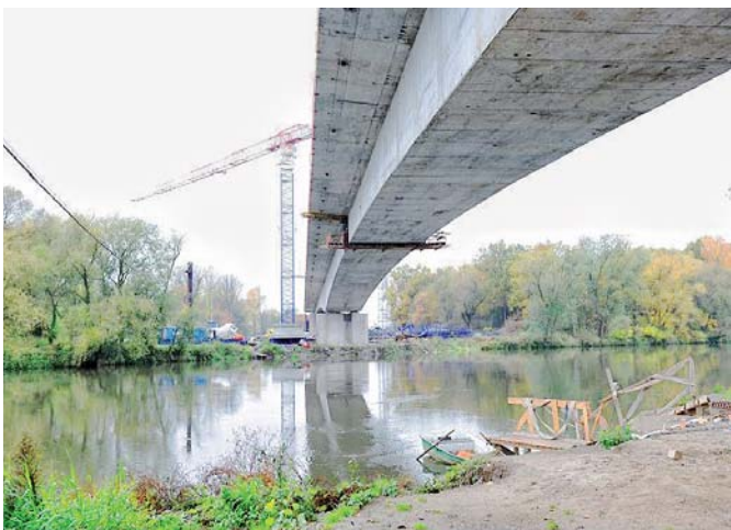
Ryc. 8. Przęsło nurtowe z poziomu łądu (widoczne deskowanie zwornika)
