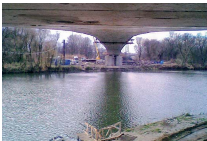
Ryc. 9. Przęsło nurtowe – widok z poziomu podpory D
