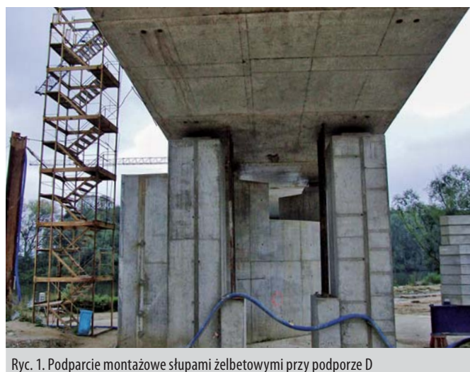
Ryc. 1. Podparcie montażowe słupami żelbetowymi przy podporze D
