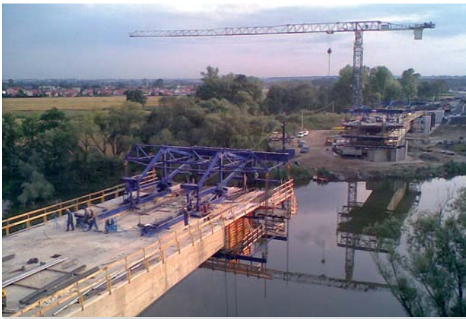
Ryc. 5. Widok na jedno z wahań wychodzące z podpory D
