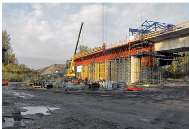
Ryc. 10. Przęsło dojazdowe A–B zrealizowano na rusztowaniach stacjonarnych
