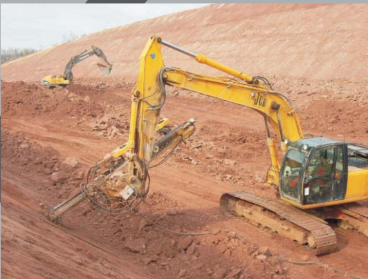
Zabezpieczenie skarp wykopu Droga ekspresowa S 7
