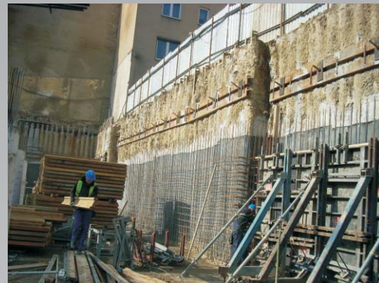
Zabezpieczenie głębokiego wykopu Filharmonia, Kielce
