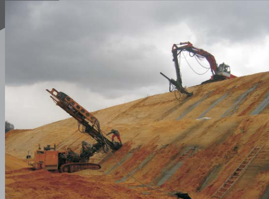
Zabezpieczenie skarp wykopu Autostrada A 1
