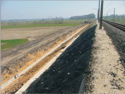
Wzmocnienie nasypu kolejowego Linia E 30
