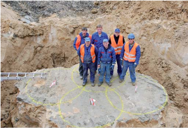
Zachodzące na siebie kolumny testowe o średnicy 2 m, fot. K. Skowroński
