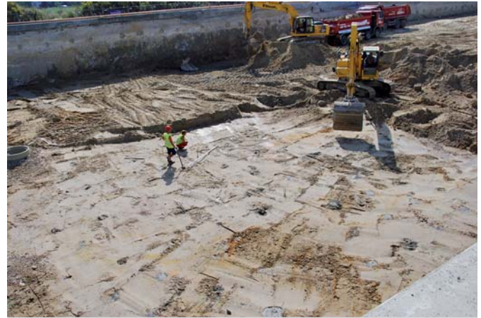
Wykop uszczelniony przez przesłonę jet grouting pomiędzy ścianami szczelinowymi, fot. K. Skowroński
