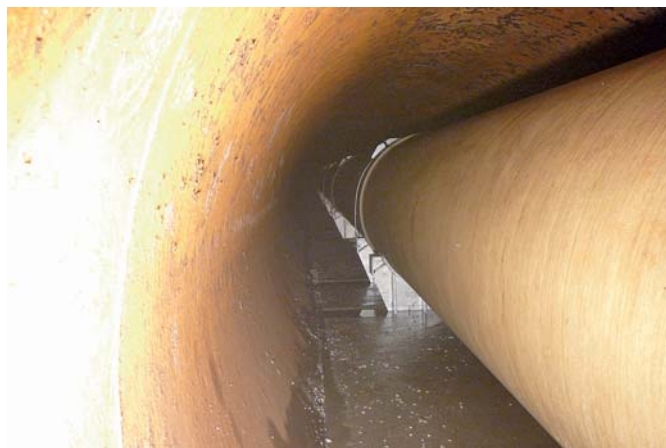
Widok zamontowanych rur DN1200 wewnątrz modernizowanej magistrali stalowej DN 2200
