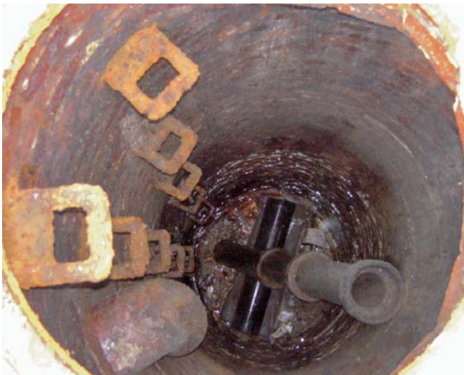
Studnia przed wykonaniem renowacji
