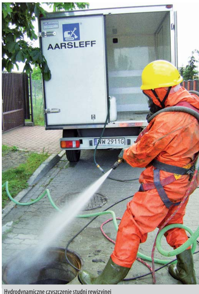
Hydrodynamiczne czyszczenie studni rewizyjnej
