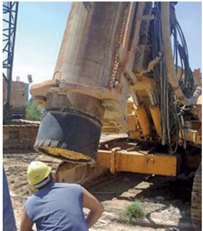
System wiercenia z jednoczesnym rurowaniem Elemex zainstalowany na palownicy
