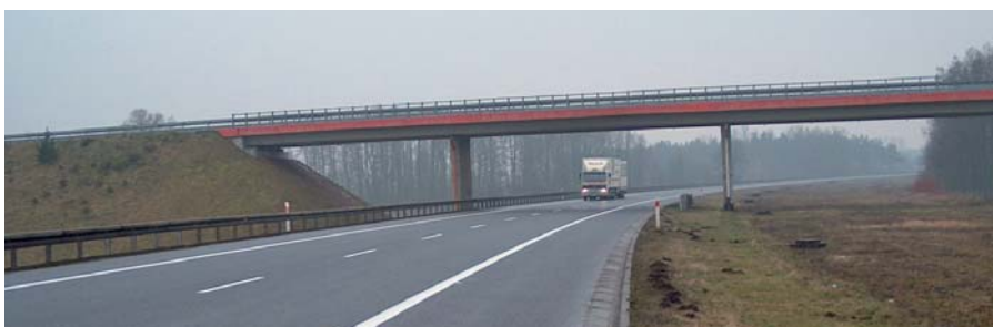
Ryc. 3. Przykład prawidłowego ukształtowania, umocnienia i utrzymania nasypu
