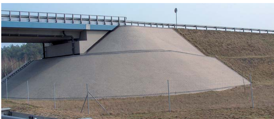
Ryc. 3. Przykład prawidłowego ukształtowania, umocnienia i utrzymania nasypu
