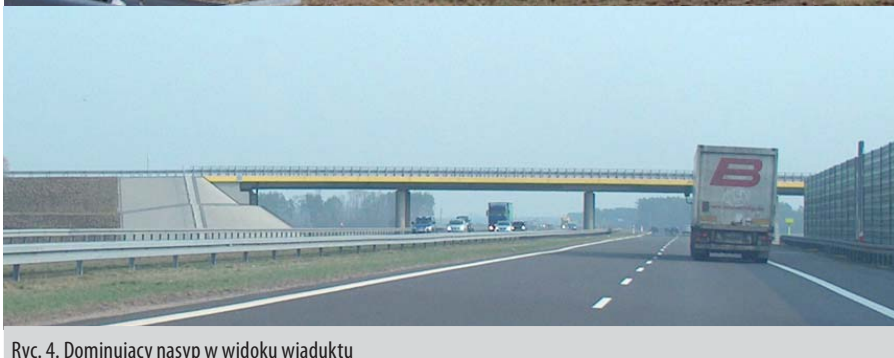
Ryc. 4. Dominujący nasyp w widoku wiaduktu
