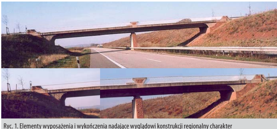
Ryc. 1. Elementy wyposażenia i wykończenia nadające wyglądowi konstrukcji regionalny charakter
