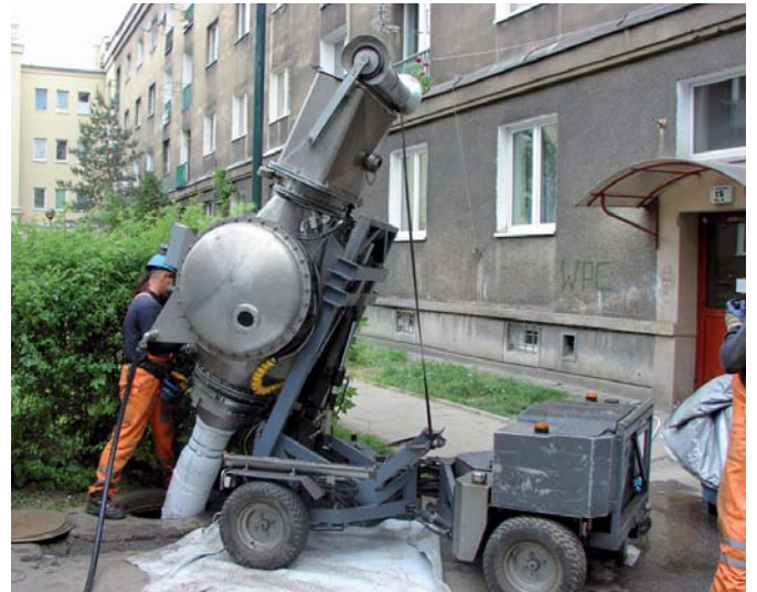
Kontrakt nr 4, zadanie nr 3/3: Renowacja kanałów nieprzełazowych metodą bezwykopową. Urządzenie do instalacji rękawów utwardzanych na miejscu budowy, os. Ogrodowe w Nowej Hucie, fot. archiwum MPWiK SA w Krakowie
