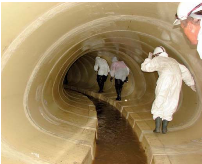
Kontrakt nr 2, zadanie nr 3/1: Wnętrze kanału przełazowego po wykonaniu renowacji metodą bezwykopową za pomocą paneli w ul. Daszyńskiego, fot. archiwum MPWiK SA w Krakowie
