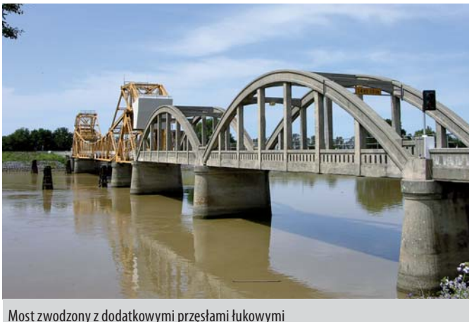
Most zwodzony z dodatkowymi przęsłami łukowymi
