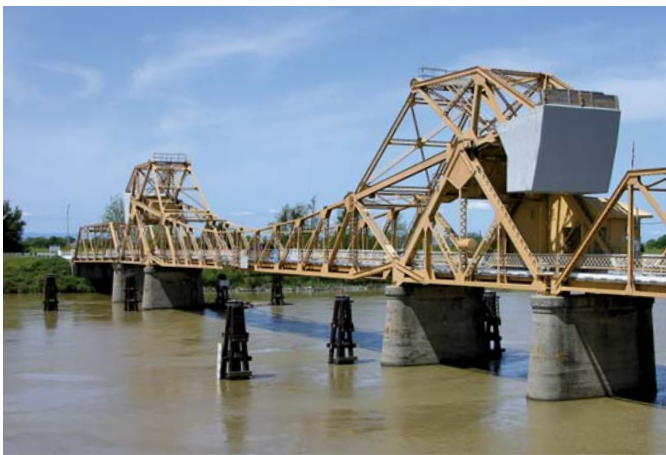
Dwuprzęsłowy most zwodzony na rzece Sacramento
