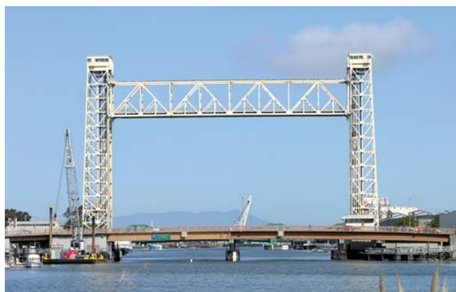
Most podnoszony w Oakland
