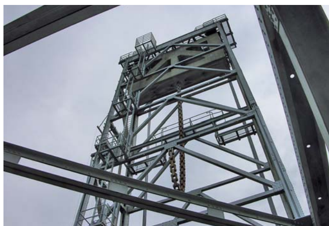
Ciężar przeciwwagi mostu podnoszonego
