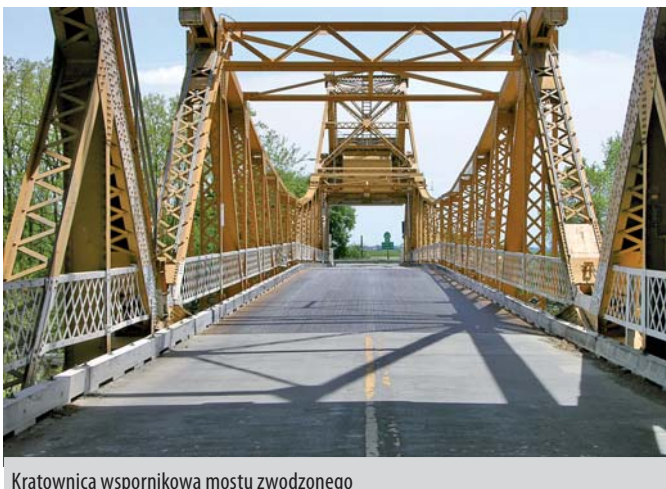
Kratownica wspornikowa mostu zwodzonego
