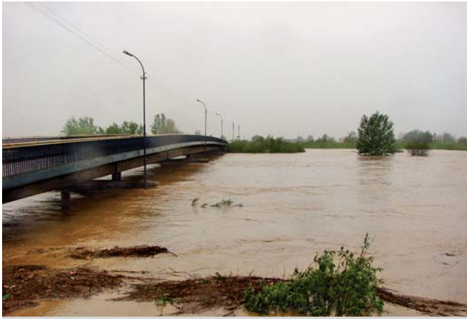
Most w ciągu drogi wojewódzkiej nr 964, Uście Solne, fot. ZDW Kraków
