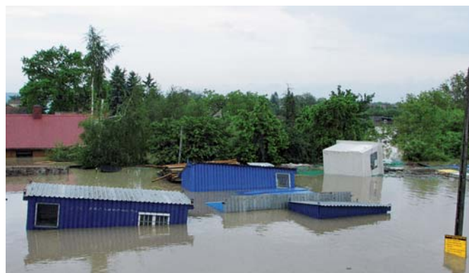
Sandomierz – zaplecze wykonawcy, fot. T. Wągorowski, GDDKiA oddział w Kielcach
