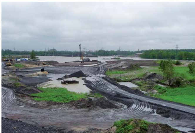
A1 Maciejów – Sośnica, fot. GDDKiA oddział w Katowicach
