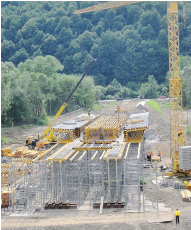
Ryc. 4. Szalowanie części ciągłej
