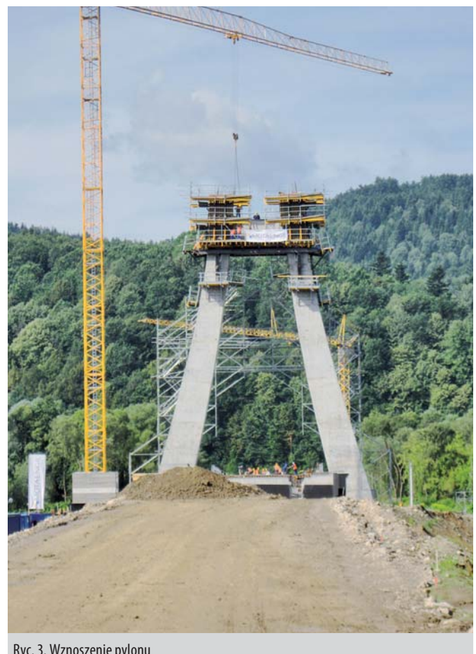
Ryc. 3. Wznoszenie pylonu
