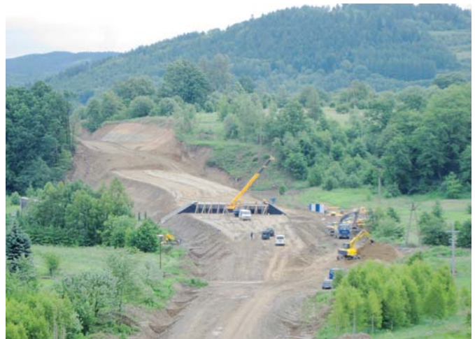
Ryc. 6. Roboty ziemne przy budowie obwodnicy
