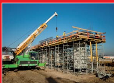
Roboty budowlano-montażowe obiektów mostowych
