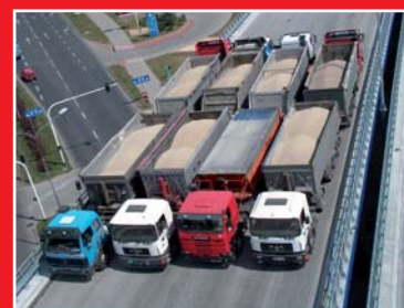
Próbne obciążenia obiektów mostowych i pali Diagnostyka, przeglądy okresowe obiektów mostowych
