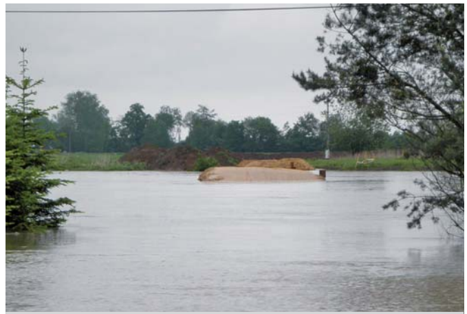
Plac budowy autostrady A4 Tarnów – Rzeszów
