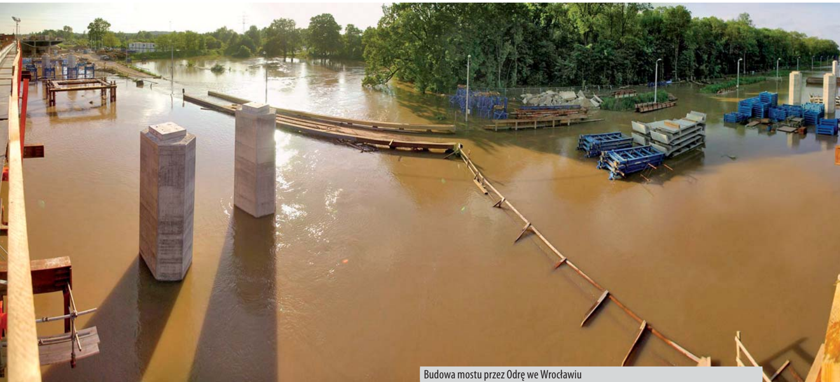
Budowa mostu przez Odrę we Wrocławiu
