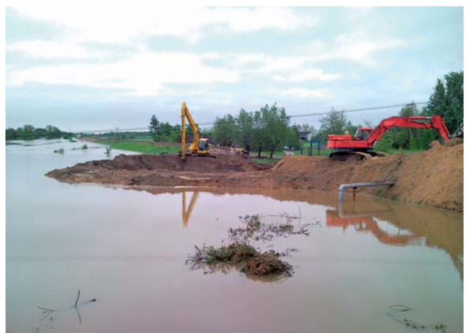
Nowy Brzeź – zabezpieczenie lewego wału rzeki
