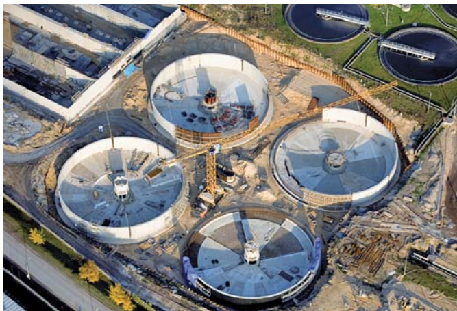
Plac budowy, fot. K. Pęczalski
