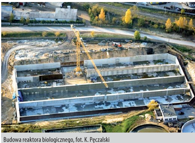
Budowa reaktora biologicznego, fot. K. Pęczalski
