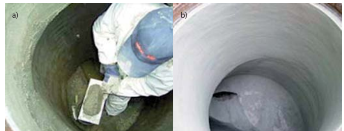
Ryc. 2. Zastosowanie produktu Ombran MHP: a) aplikacja produktu w studni; b) gotowa studnia poddana naprawie produktem Ombran MHP
