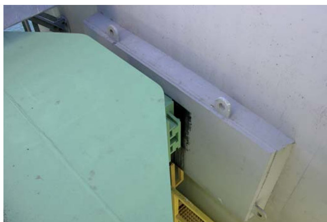
Ogranicznik ustroju nośnego Tacoma Narrows, 2007
