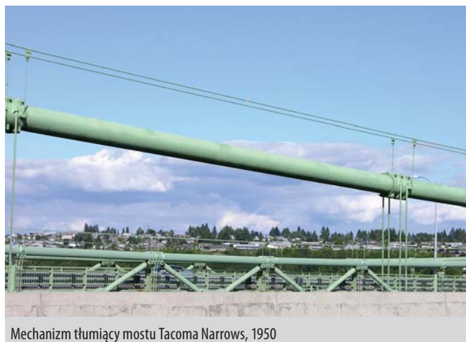
Mechanizm tłumiący mostu Tacoma Narrows, 1950
