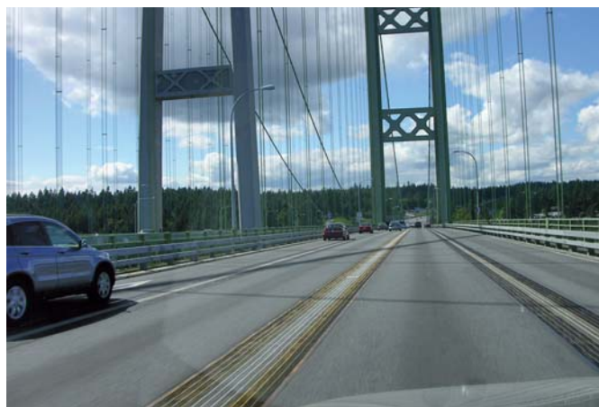
Wzdłużne ciągi otworów w ustroju nośnym Tacoma Narrows, 1950
