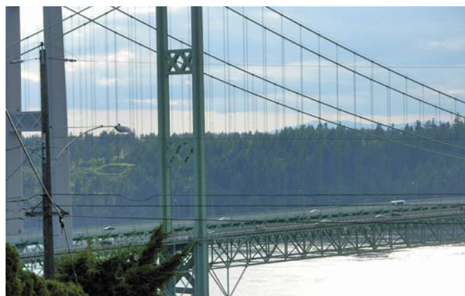
Kratownica usztywniająca mostu Tacoma Narrows, 1950
