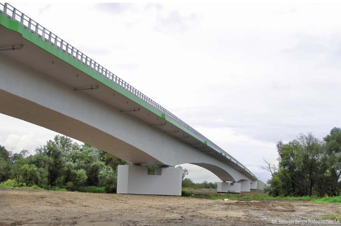
foto: Bilfinger Berger Budownictwo SA
